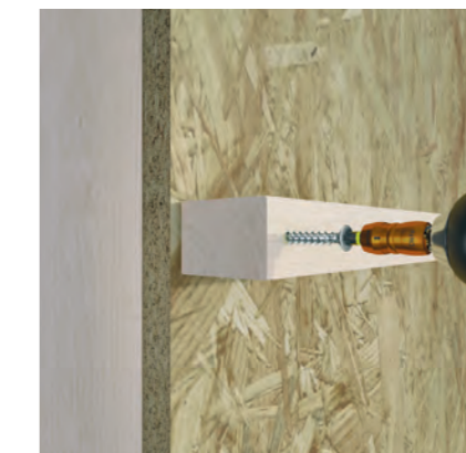
Bevestiging van regelwerk t.b.v. installaties
